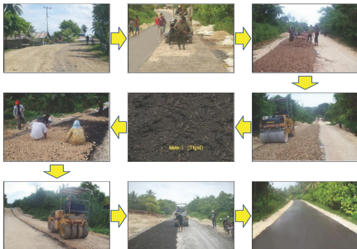
Gambar 5.8 Aplikasi LPMA pada tipe jalan dengan lalu lintas rendah.
