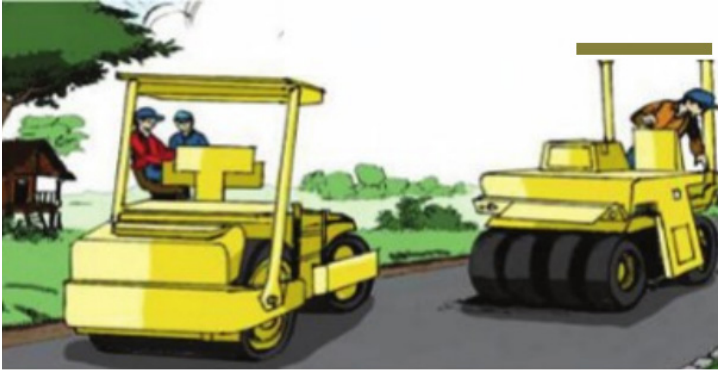
Gambar 6.18 Proses pemadatan CPHMA dengan menggunakan alat pemadat roda baja dan roda karet.
