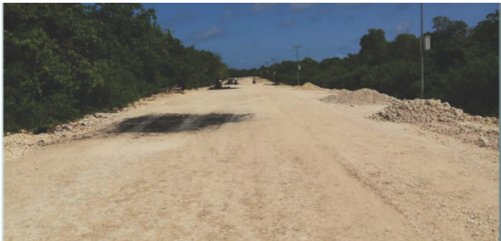
Gambar 5.4 Penghamparan lapis fondasi batu kapur sebelum aplikasi Butur Seal Asbuton CBR Min 30%
