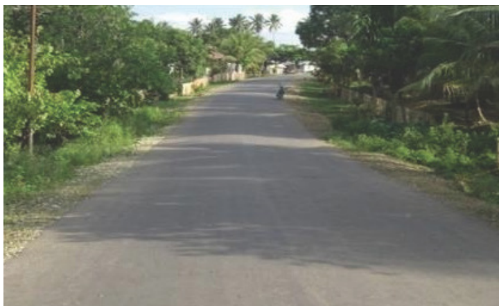
Gambar 5.9 Kondisi jalan dengan teknologi LPMA setelah 3 tahun pemakaian.
