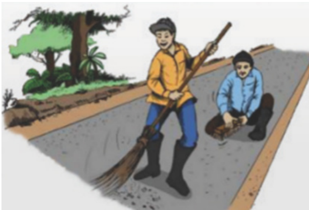
Gambar 6.10 Persiapan lapis di bawah Butir seal.
