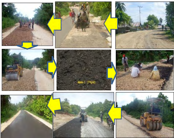
Gambar 24. Aplikasi LPMA pada Tipe jalan dengan lalulintas rendah
