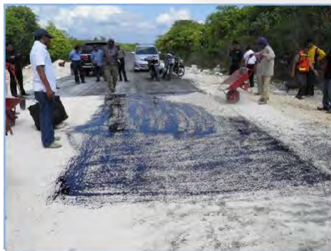
Gambar 21. Pemanfaatan Cape Asbuton Seal (CAS)
