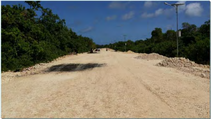
Gambar 20. Penghamparan Lapis Pondasi Batu Kapur sebelum aplikasi butur seal Asbuton CBR Min 30%
