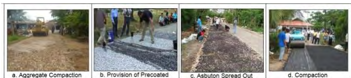
Gambar 19. Urutan Kerja dalam pemanfaatan Butur Seal
