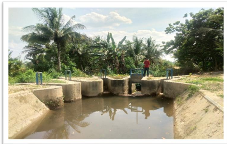
Gambar 3. Bangunan Bagi sadap
